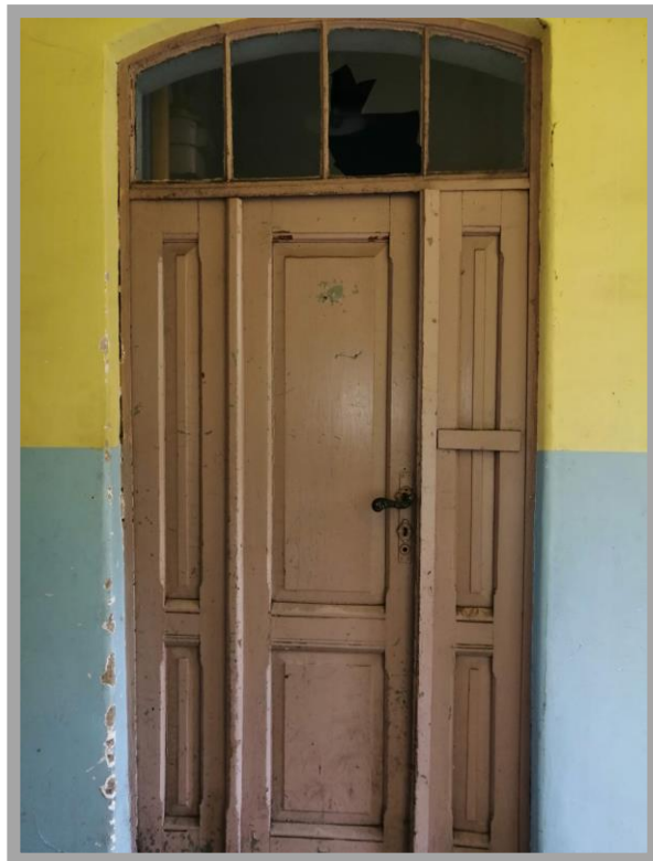
Fot. 6 Detal – drzwi do klatki schodowej
