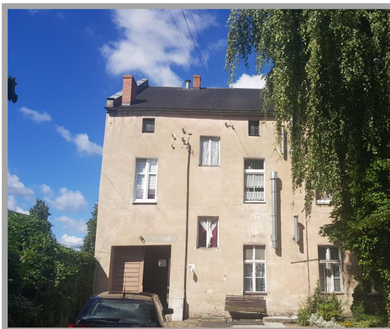
Fot. 2 Elewacja tylna
