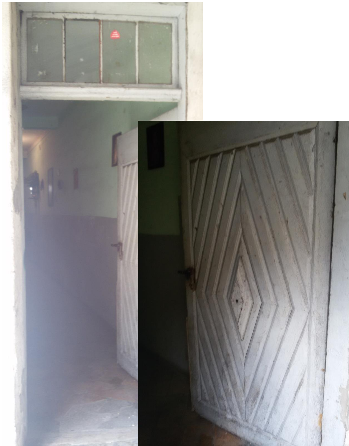
Fot. 3 Drzwi zewnętrzne tylne
